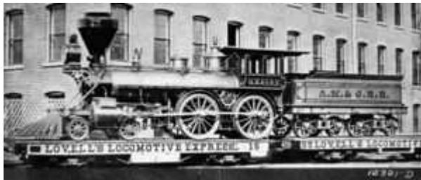
4-4-0 della Atlantic, Mississippi & Ohio Railroad #87, consegnata nel 1873 da Mason Machine Works di Taunton, Massachusetts. Si tratta di una locomotiva con scartamento ridotto per cui è consegnata su un carro. Da notare la decorazione elaborata e la forma a cono del fumaiolo per eliminare le scintille – la #87 è alimentata a legna
