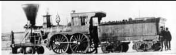
4-4-0 della Atlantic and St. Lawrence Railroad Coos circa 1856 in Longueuil, Quebec. L'interasse delle ruote anteriori, delle motrici è ancora ridotto come per i carrelli del tender .
